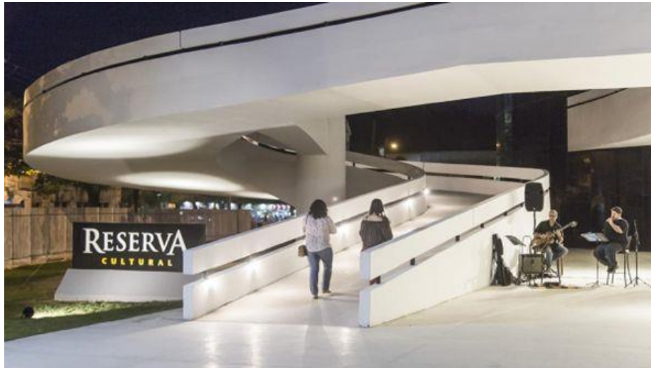
Rampa que dá acesso às salas de cinema (Reprodução: Reserva Cultural)
